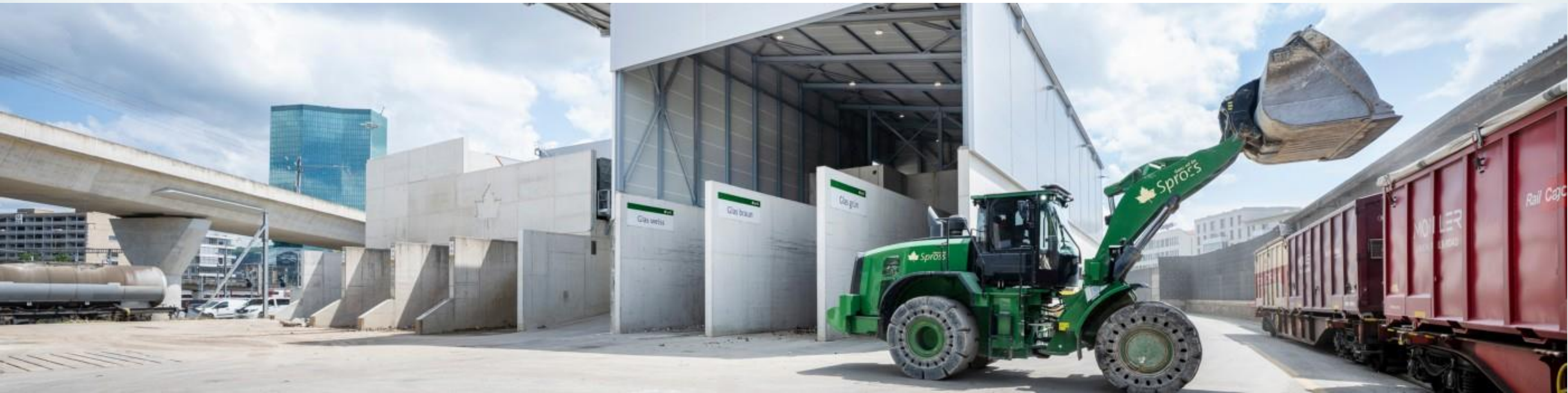
Imagen: Martin Gasser - Planta de Reciclaje de Zúrich RWZ - Concreto Spross
