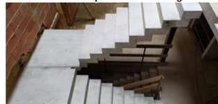
**escalera prefabricada hormigón**
