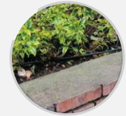
Sistema de recolección de agua lluvia
